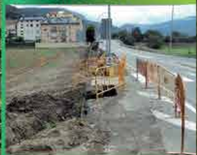
Canalització gas i pavimentació camí Sant Antoni
