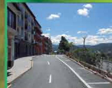
Asfaltat Serrat Capella
