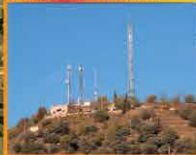
Nova Torre de telecomunicacions al Pla de les Forques
