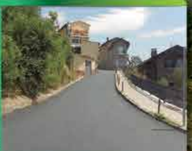
Asfaltat Poble Sec
