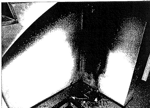
Estat en què va quedar l'interior de l'immoble després de l'incendi.
