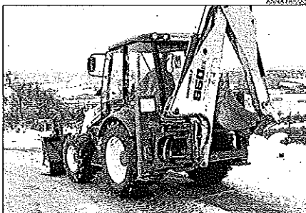
Una retroexcavadora netejant l'accés a Covet.
