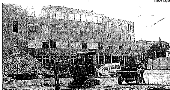
►► Les obres de la nova llar d'infants de la Seu.
