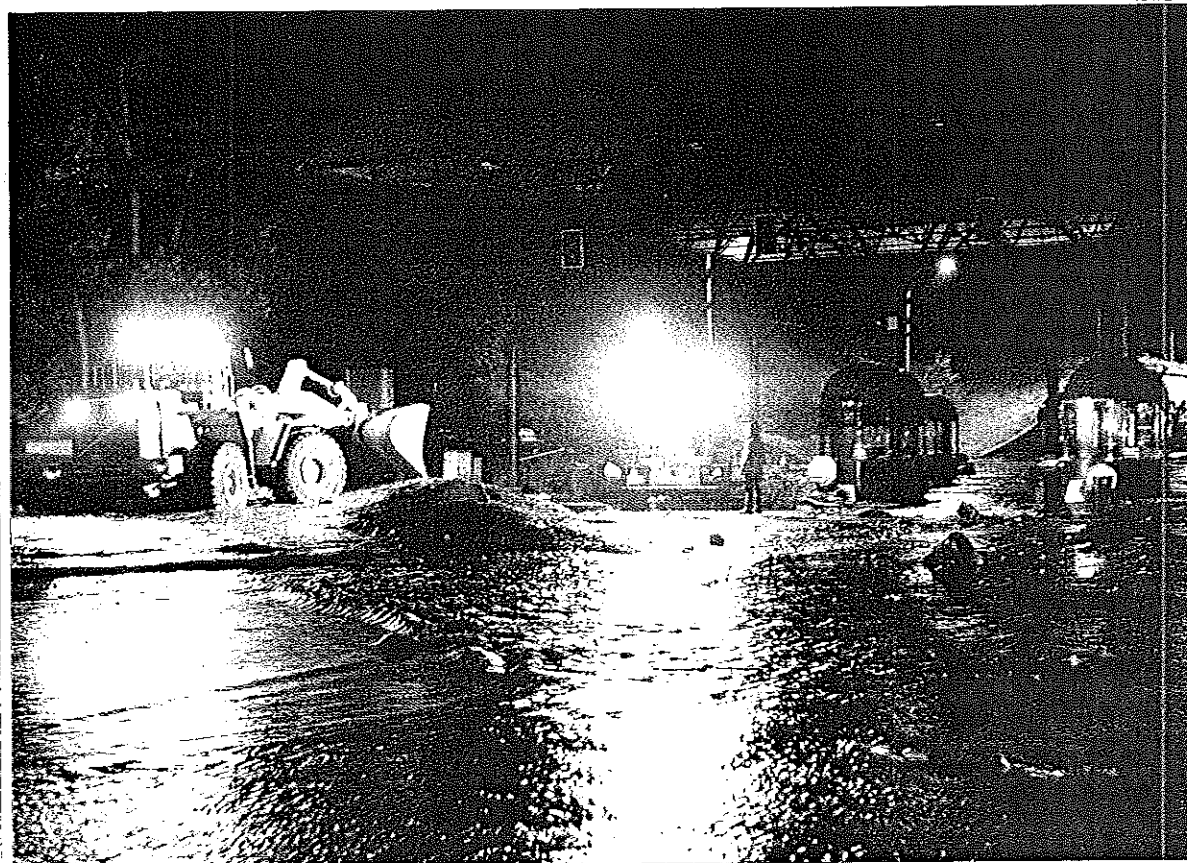
► La feina feta ► Una de les moltes excavadores que, amb els Bombers, treballen a la zona de les cabines de la Policia, ahir a mitjanit.
