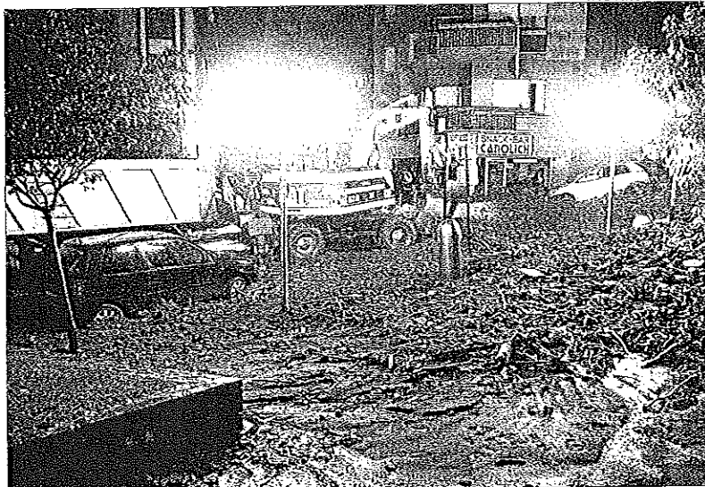
Treballs de desenrunament al Pont de Fontenada, a Sant Julià de Lòria, amb la riuada de fang.
