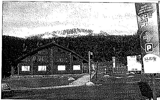
L'estació de Lles de Cerdanya ha vist millorats els accessos en els darrers mesos, treballs previs al començament de temporada.
