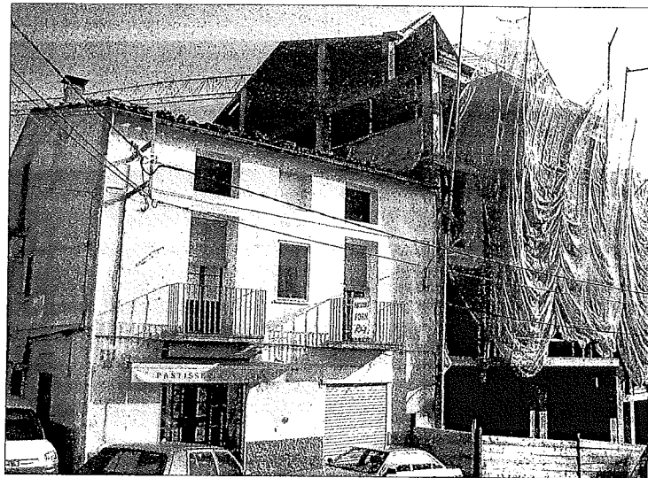
Este es el edificio que la dirección de Urbanisme ha declarado ilegal
