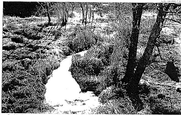
► Sortida d'aigües de la depuradora de Montferrer, amb el riu Segre al fons, ahir.
