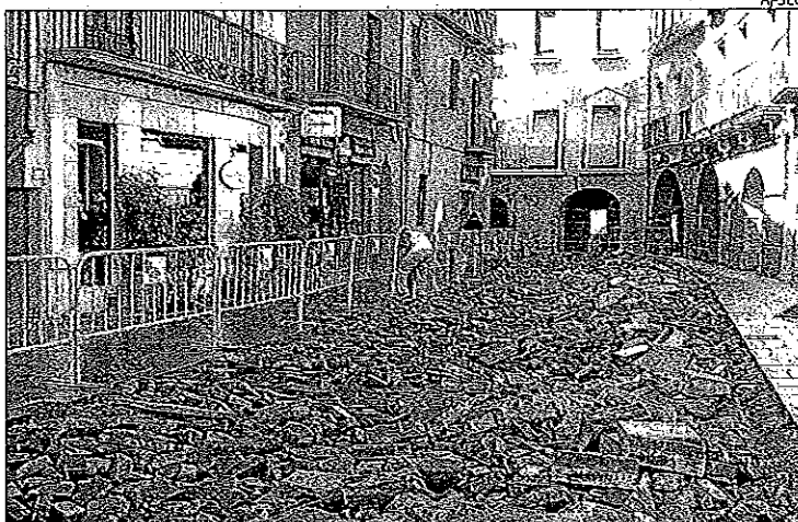
El carrer Major de la Seu ja ha estat aixecat per tal de reformar-lo
