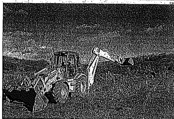
Una màquina retirava ahir la vegetació als marges de la pista de l'antic aeroport de la Seu.
