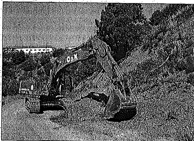
Obras en el camino que une Castellciutat con Montferrer
