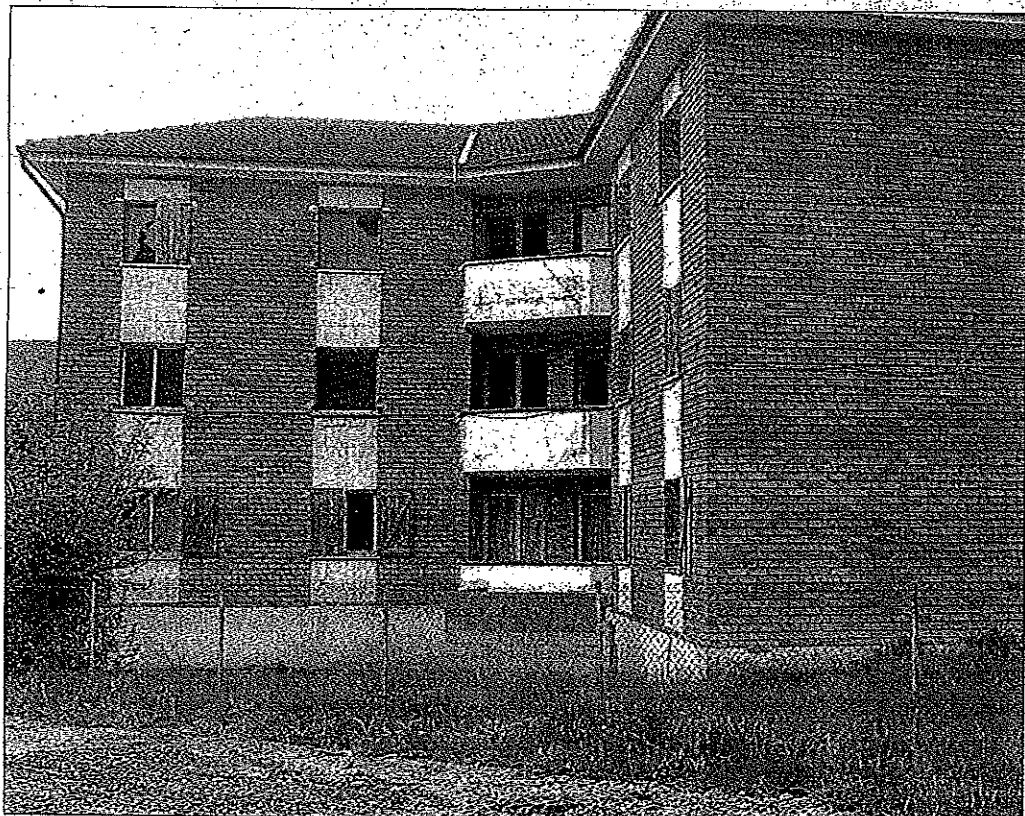
El edificio del cuartel de la Guardia Civil en Oliana está abandonado desde hace años
