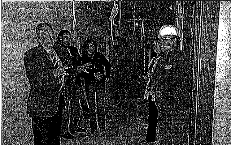
El gerent, Jordi Riba, va fer ahir una visita a les obres de reforma del centre hospitalari.
