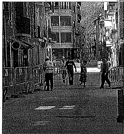
Les obres al carrer Major de la Seu, que acabaran a la tardor.
