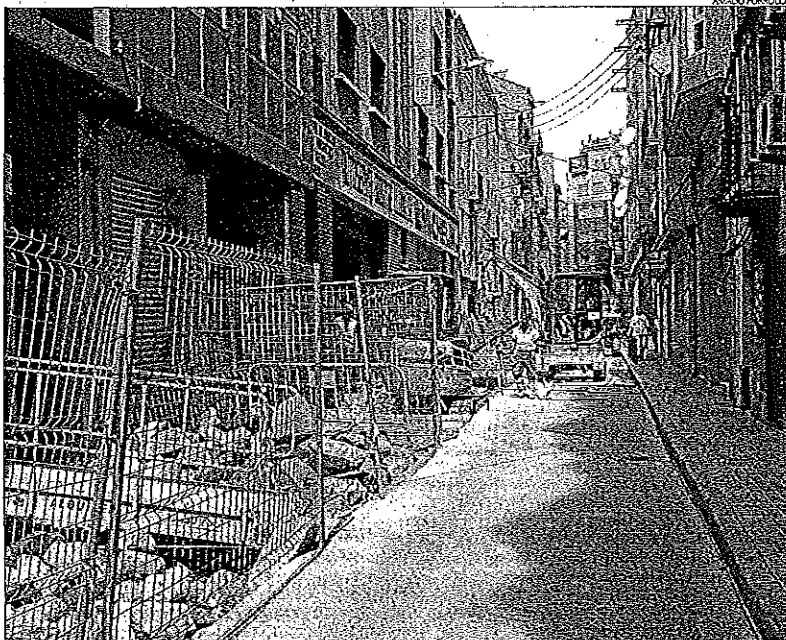
Imatge de les obres de reforma del carrer Joan Baget, a Lleida ciutat.
