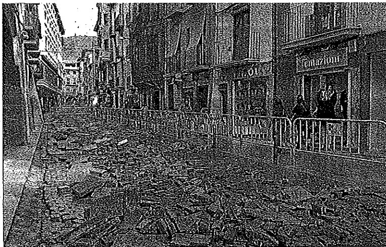
Les obres de reforma del carrer Major van començar dilluns passat.
