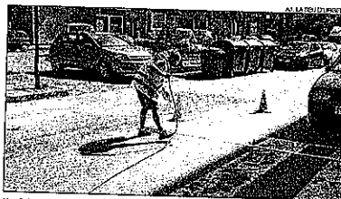
Un dels operaris fent les tasques de pintura.
