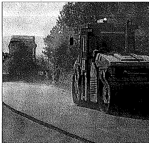
Treballs d'asfaltatge de la via d'accés a l'aeròdrom.
