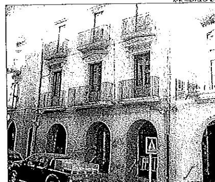
La façana de l'immeuble on es vol ubicar l'Espai Ermengol.
