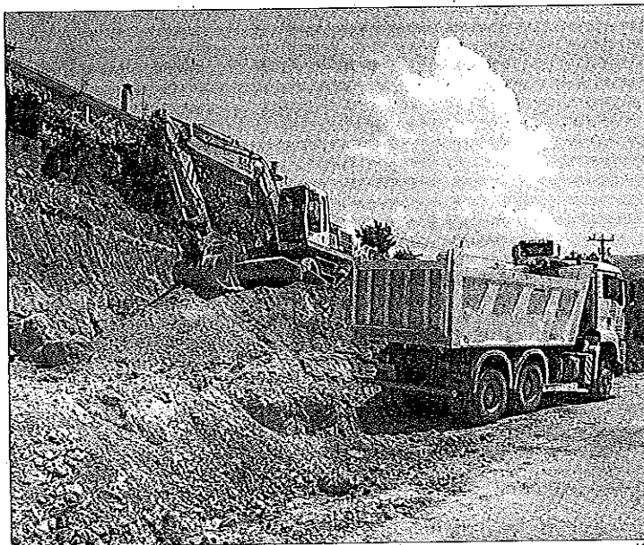
Los trabajos de construcción del centro Dinosfera ya han comenzado
