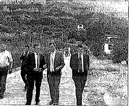
La comitiva visitant les obres del camí de la Canaleta
