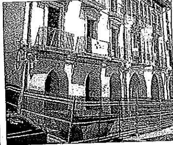
Les obres de l'Espai Ermengol
