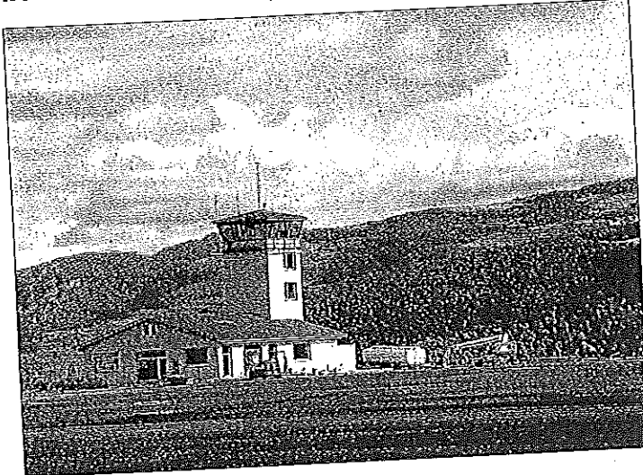
Les obres a l'aeròdrom de la Seu.
