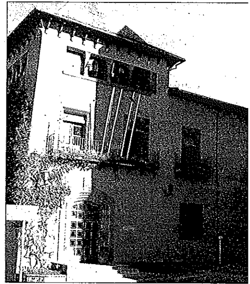
Les obres han estat adjudicades aquesta setmana.
