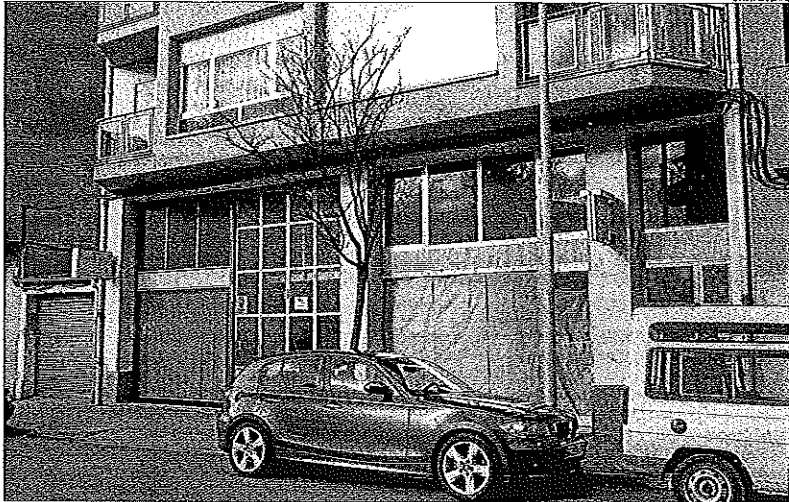
Imatge dels baixos on hi ha prevista la construcció del tanatori de la Seu d'Urgell.
