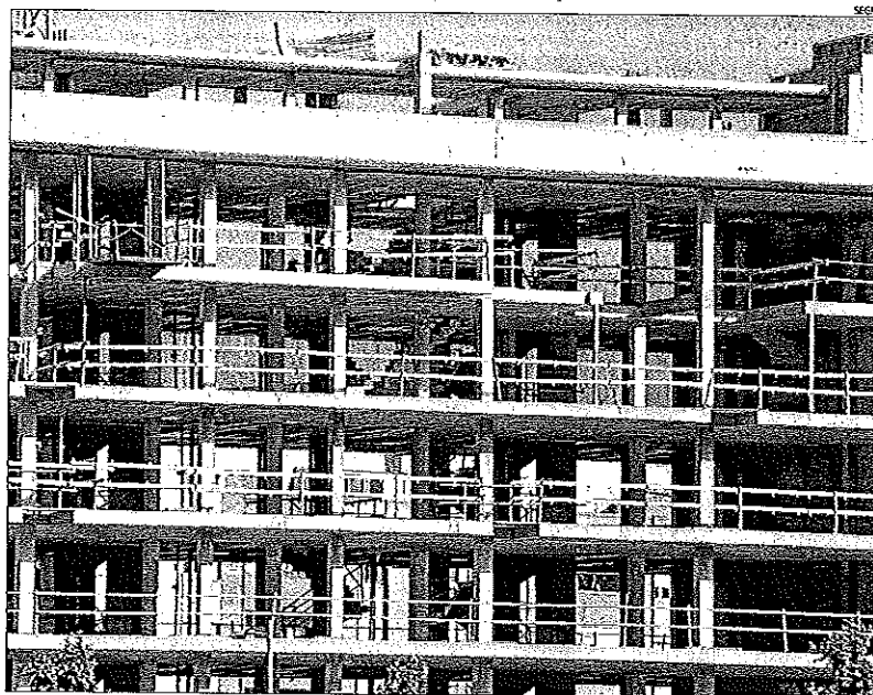
Una promoció de pisos en construcció a Lleida ciutat.
