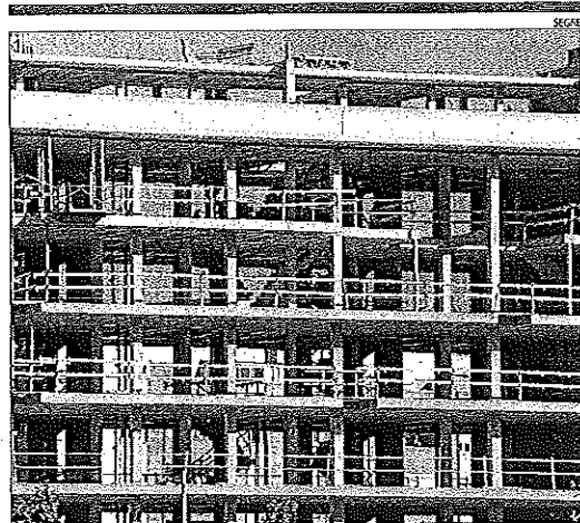
Imatge d'arxíu de pisos en construcció a Lleida.
