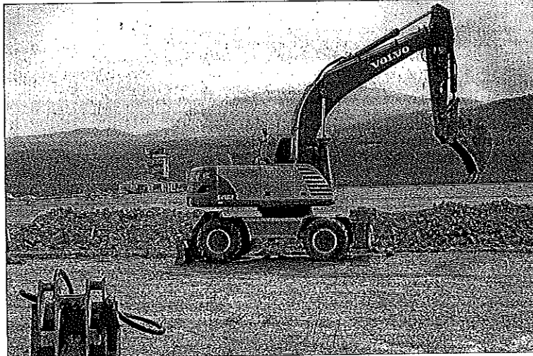
Imatge de l'inici de les obres per a la construcció d'hangars a l'aeroport, al setembre.
