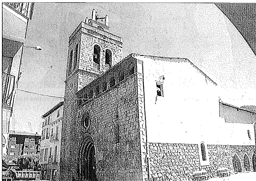
Las obras se efectuaron en la iglesia de Santa María de Organyà
