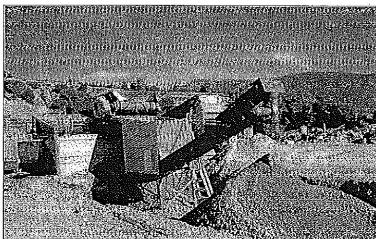
La planta de reciclatge a Benavarre.
