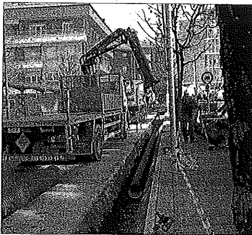
Aspecte de les obres, ahir a un carrer de la Seu.
