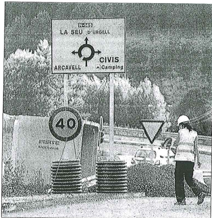
Una treballadora a les obres de l'N-145.
