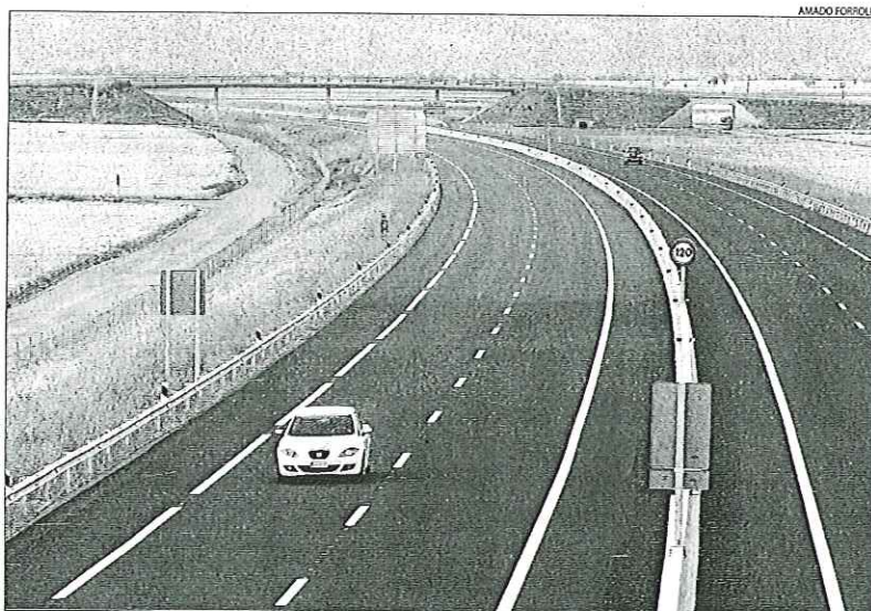
El tram entre Almenar i Rosselló de l'autovia Lleida-Aran, l'únic construït i obert des de dissabte.
