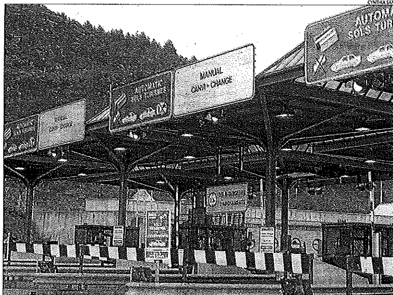
Imatge d'arxiu dels peatges a l'entrada al túnel del Cadí.
