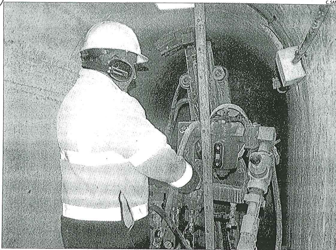
Un dels tècnics actuant en una de les galeries interiors de la presa d'Oliana.
