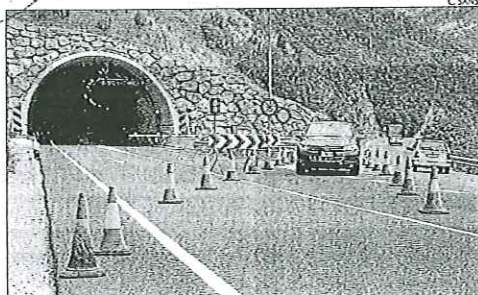
Tancament del túnel el passat 6 d'agost.
