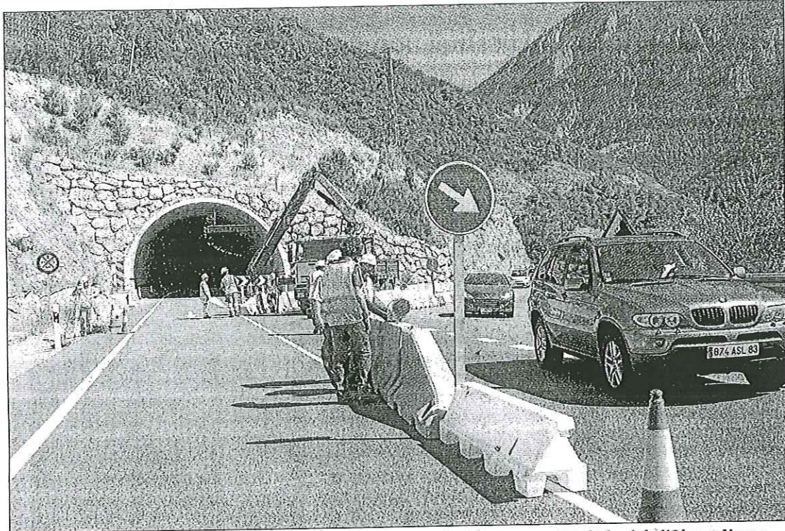
Desviació del trànsit per l'antic traçat de la carretera després del tancament del túnel de l'Obaga Negra.
