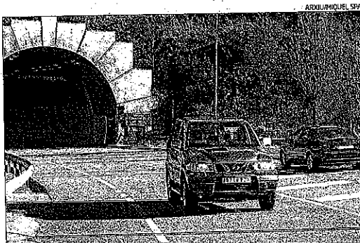
Dos vehicles a l'accés de la boca sud del túnel del Cadí
