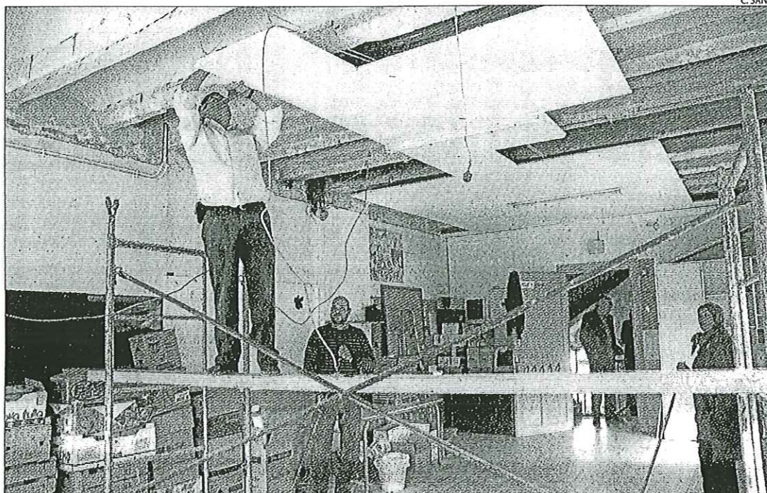
Familiars d'alumnes fan reparacions per recuperar l'antiga escola de Peramola.
