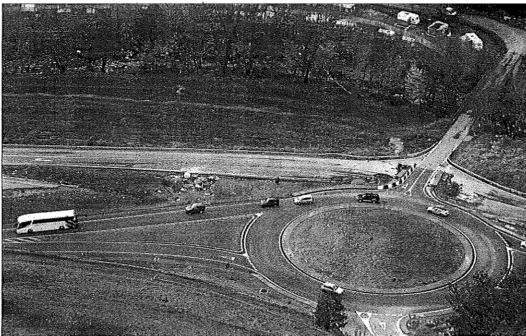
Tram en obres de la carretera N-145, a l'altura d'Anserall.
