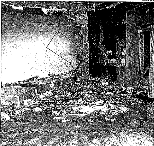
Estat en què va quedar el local dels Testimonis de Jehovà de la Seu després del foc.
