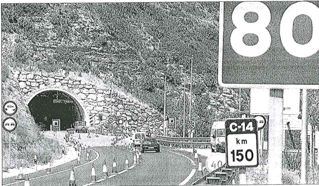
El túnel dels Espluvins, que es va tallar a la circulació dimarts per portar-hi a terme treballs de manteniment.
