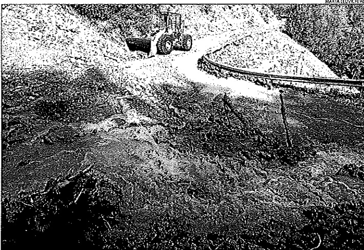
Les màquines treballaven en la neteja de la carretera d'accés a la pista de Port Ainé.
