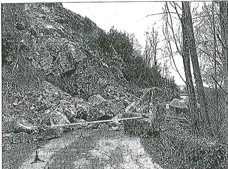
L'accés a Bescaran, tallat per un desprendiment de roques divendres passat.
