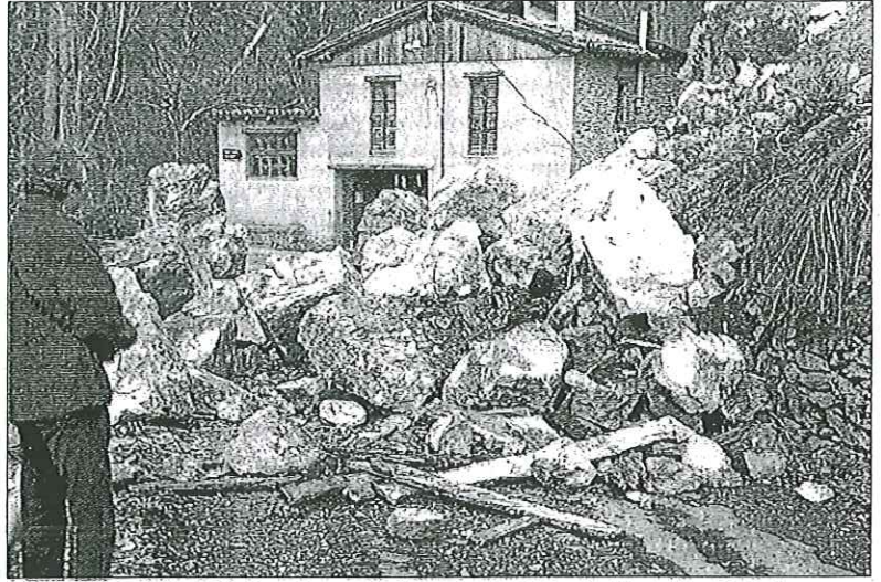
Imatge captada després del desprendiment des del costat més pròxim al poble en direcció als afores.
