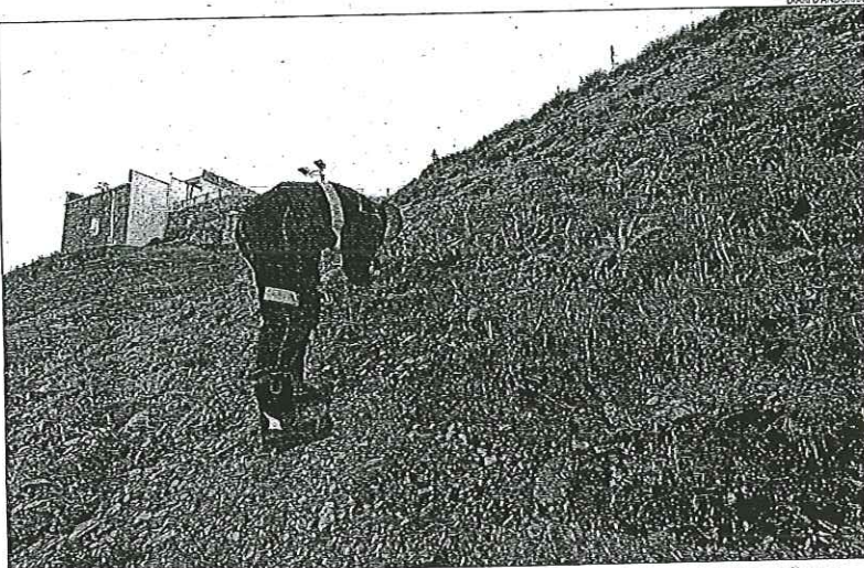
Un bomber comprova la possible filtració del combustible vessat al pendent al costat de la gasolinera.
