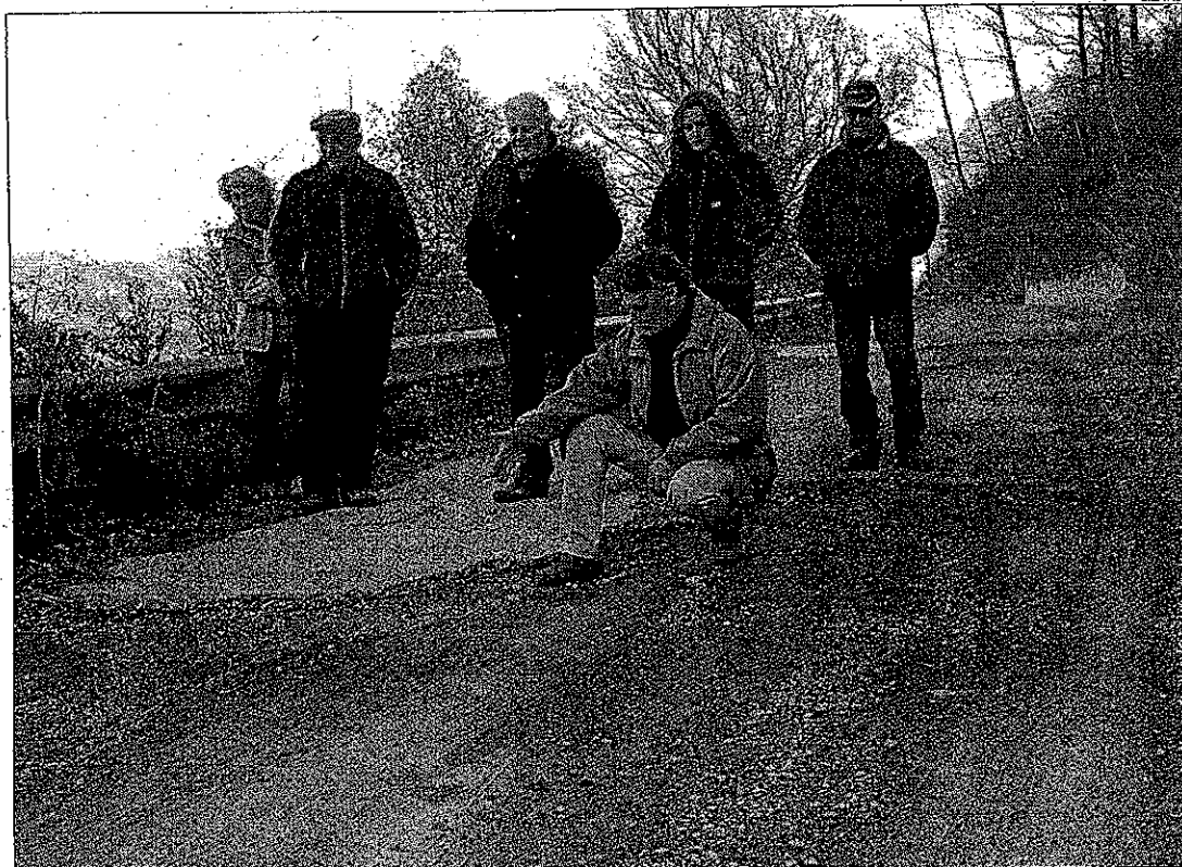
Els veïns mostren l'estat del paviment.
