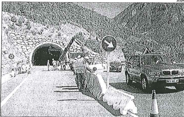
Imatge d'arxiu del túnel de l'Obaga Negra en obres el 2012.
