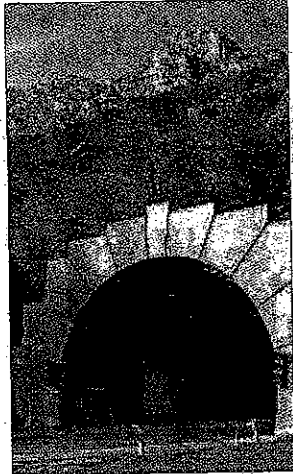
► Una de les entrades al túnel.
