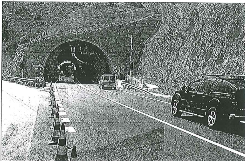
El túnel de la Obaga Negra presentaba varias patologías en su revestimiento que se han solucionado
