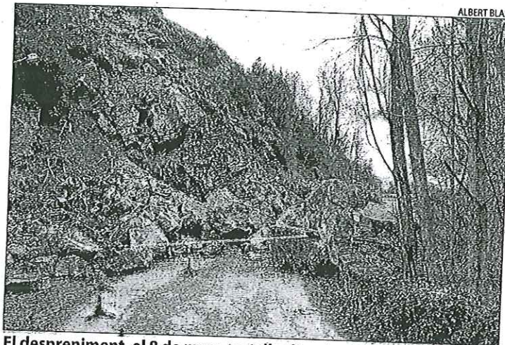
El desprendiment, el 8 de març, va tallar l'accés a Bescaran.
