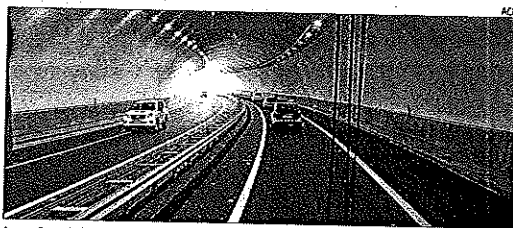
Interior del túnel del Bordar ahir, després de la inauguració
