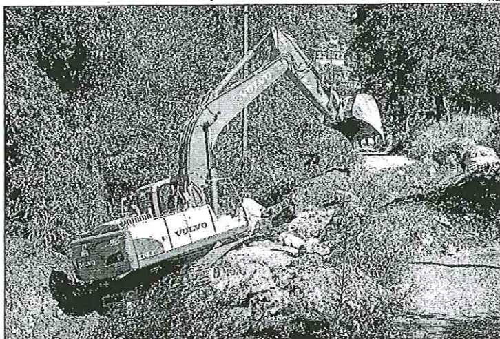
Una màquina reparant el camí de Nabiners, un dels afectats.
